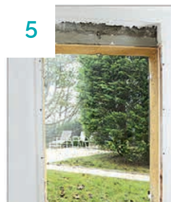
5| Support prêt à l'isolation
