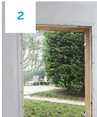
2| Dépose des ouvrants et de la traverse
