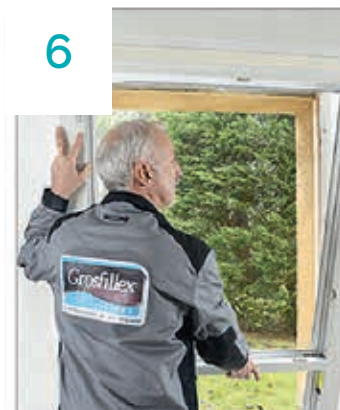
6| Pose de la nouvelle menuiserie équipée du volet, celui-ci se positionne derrière le linteau et ainsi le clair de jour est préservé
