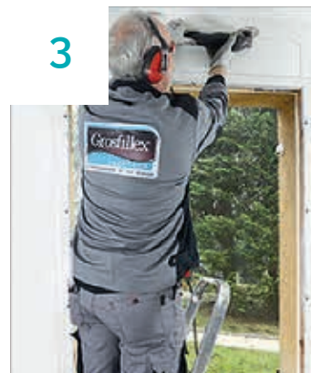
3| Découpe de l'isolation intérieure (doublage polystyrène et Placoplatre)
