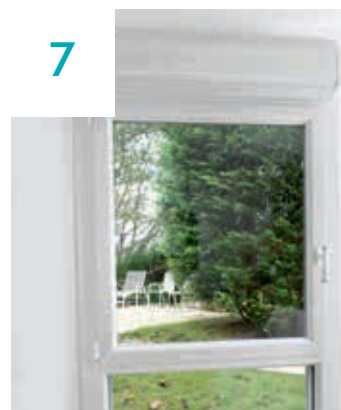
7| Menuiseries posées finitions effectuées. Nettoyage final du chantier.
