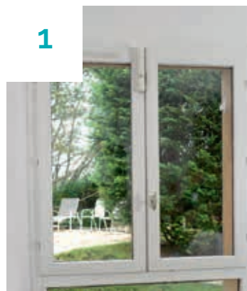
1| Vue intérieure avant travaux (fenêtre bois)
