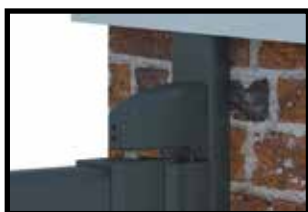
Pivot CUPRO avec cache NORYL laqué de la couleur du portail
